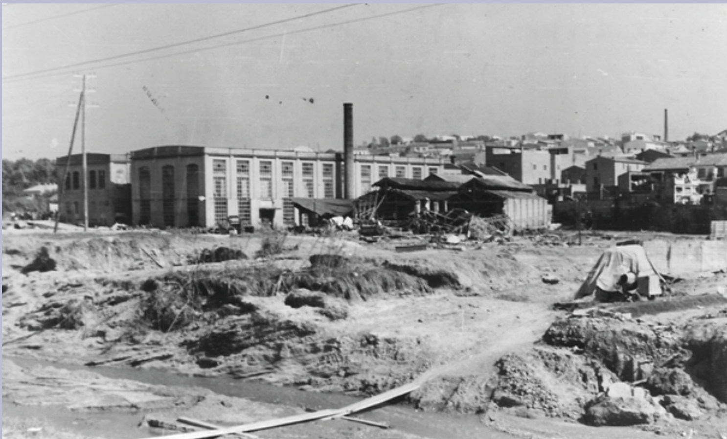
Imatge dels efectes ocasionats per la rierada a la zona de l'Escardívol. Fotografia: Joaquim Julià Roca
